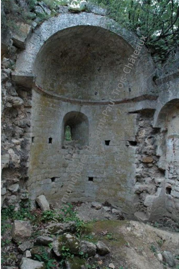
Clansayes : chapelle Saint Ferréol (2008)
