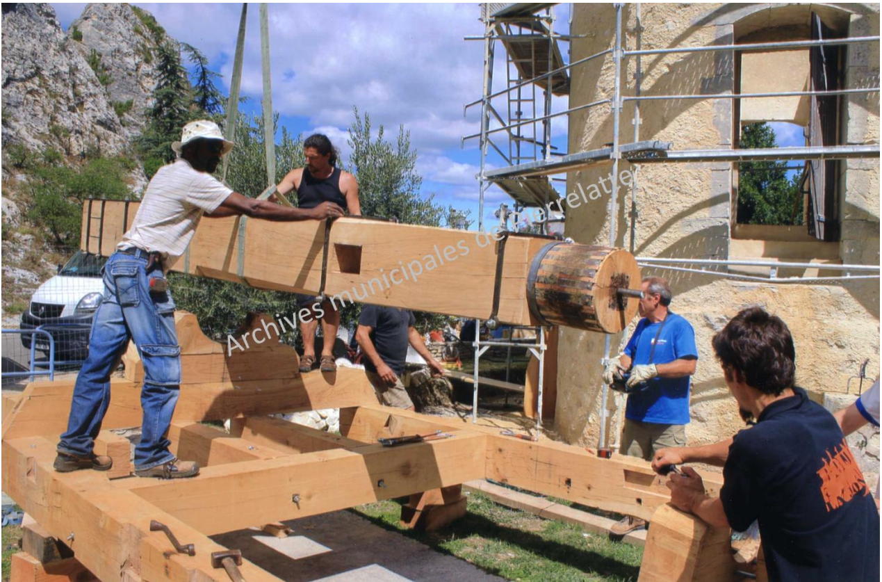
Positionnement de l'arbre moteur. AmP, 101Fi9, cl.B.Detivaud, 2012
