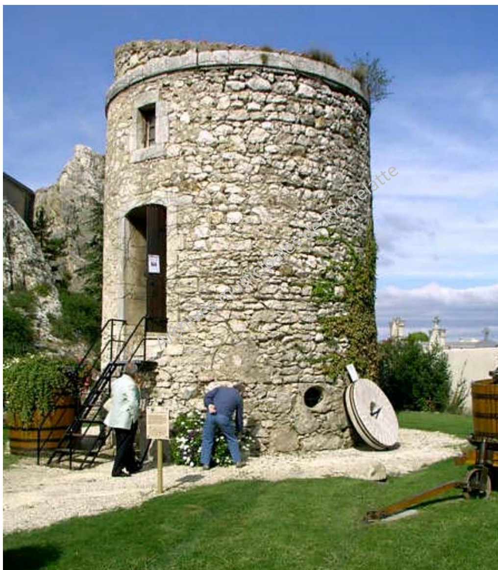
AmP, le moulin avant restauration (2007)
