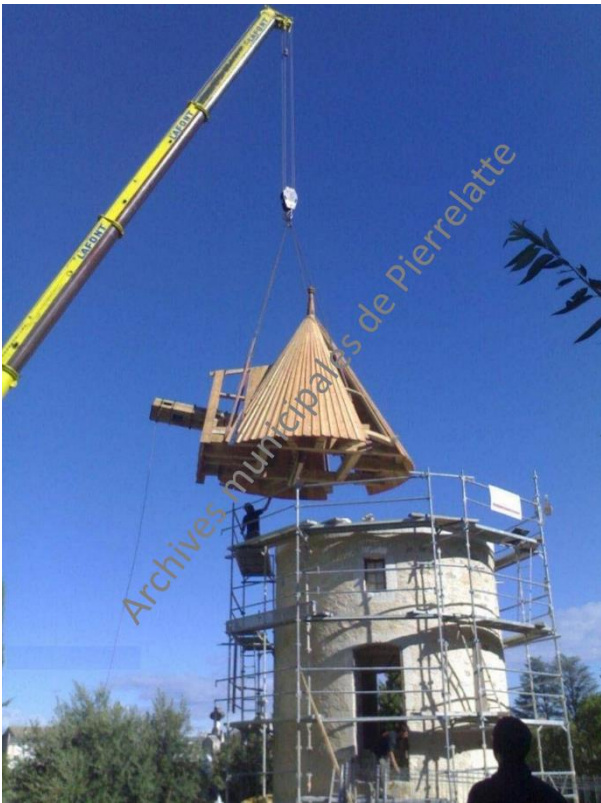
Toiture et artifices assemblés sont posés sur la Tour. AmP, 101Fi11, cl.B.Detivaud, 2012
