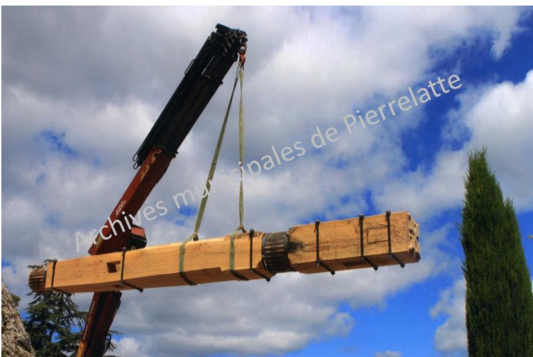
Dépose de l'arbre moteur sur lequel seront fixées les ailes. AmP, 101Fi8, cl.B.Detivaud, 2012
