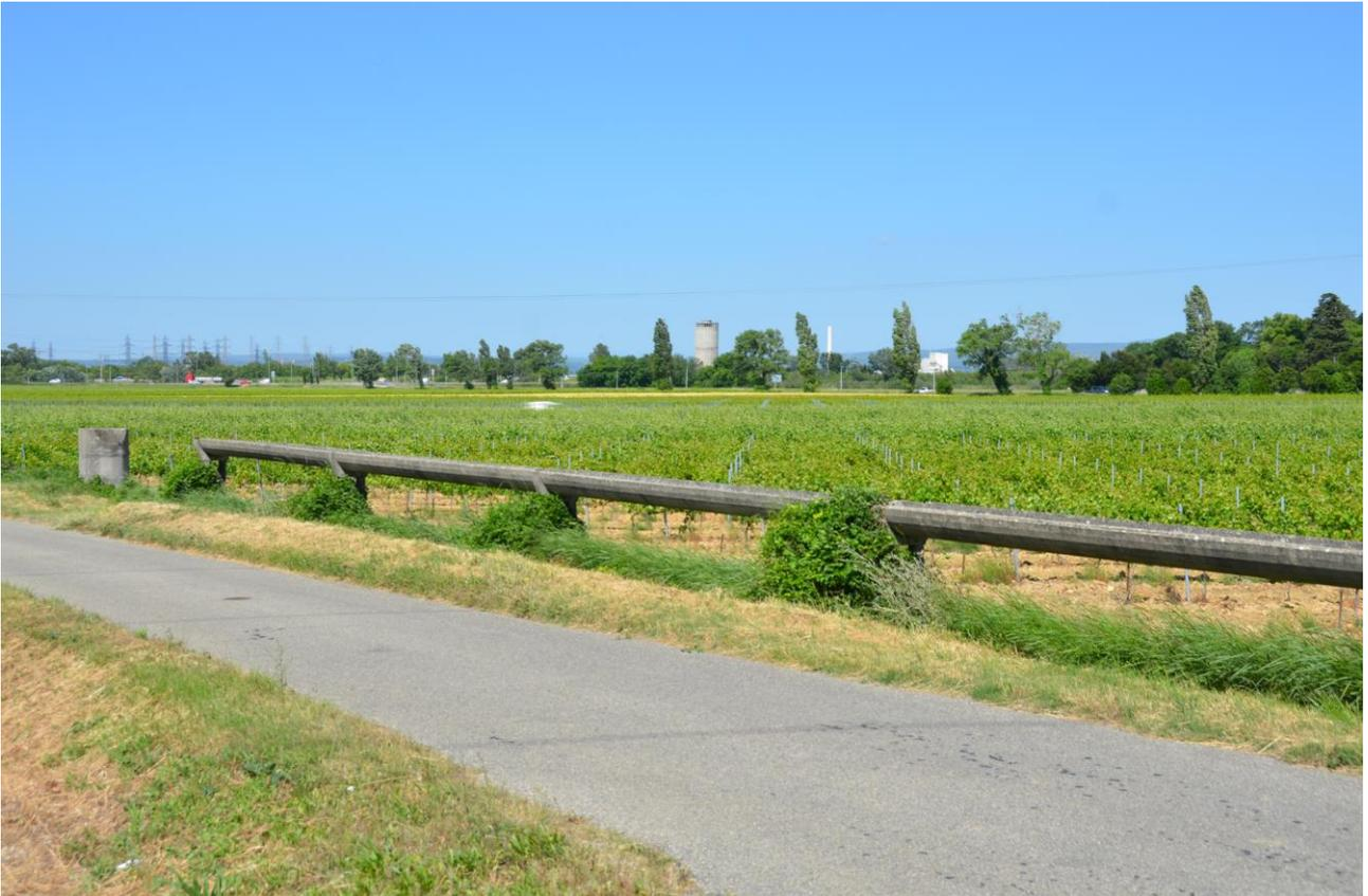
Canalisation à ciel ouvert encore visible et utilisée au nord du quartier des Lonnes.
