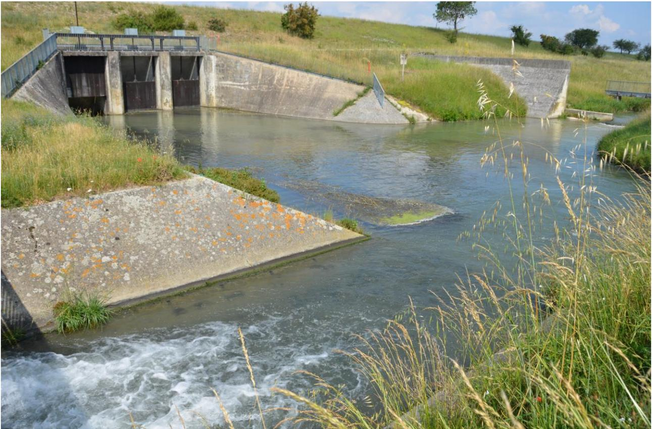
Entrée du siphon, entre La Calamande au nord et Chamier au sud, qui reçoit les eaux du canal de fuite, celle de la Robine à cet endroit, coulant du sud au nord (1<sup>er</sup> plan) et du contre-canal avec les eaux des Echaravelles, coulant du nord au sud (2<sup>e</sup> plan sur la droite de l'image).
