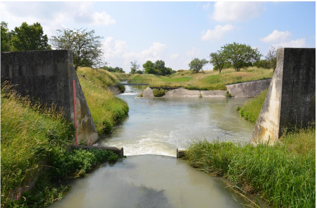
Au nord de Chamier, section du contre-canal en amont (1<sup>er</sup> plan) et canal de fuite en aval (au fond) du siphon, empruntant en grande partie le lit de l'ancien canal de Pierrelatte.
