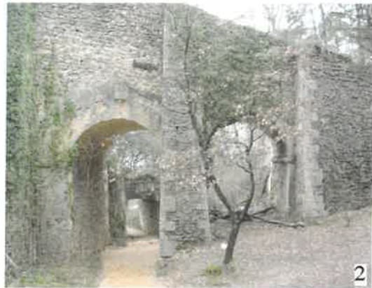
Le plan incliné conduisant aux carrières : Le cheminement (1), le mur de soutènement (4) et les ponts (2, 3)
