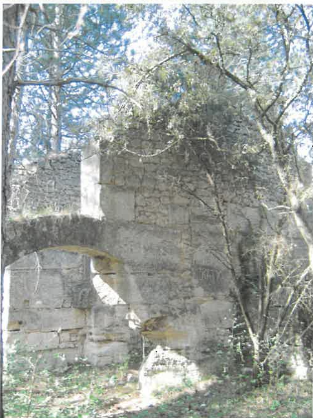
Ci-dessus, l'ancien frein du XVIIe siècle, et à droite éléments bâtis du plan incliné qui lui fait suite : en haut le pont, en bas mur de soutènement et contrefort.
