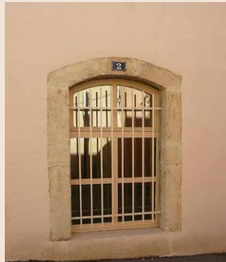
Enduit s'arrêtant au nu de la pierre de taille, la limite pierre/enduit est régulière.
