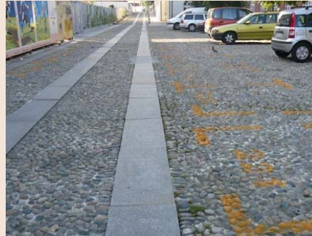
Calade pour l'ensemble de la rue et dalles de granit pour les bandes de roulement (Turin, Italie)
