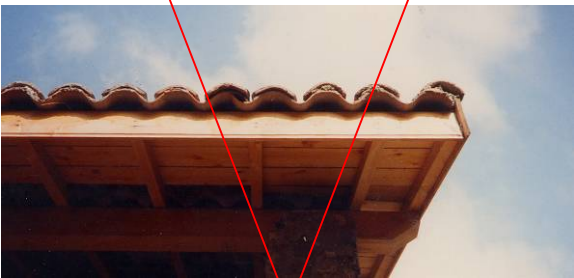
2- Les plaques d'étanchéité visibles au niveau de l'égout ou de la rive.
