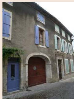
Ici le rez-de-chaussée est marqué par un porche avec voussure en pierre de taille et deux portes avec encadrement en pierre de taille. Les ouvertures des étages supérieurs sont alignées et proportionnées. Le simple changement de couleur des volets suffit à marquer le changement de parcelle.
