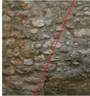
Enduit pierre-vue en ciment
