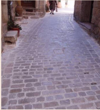
Pavés rejointoyés au mortier de chaux avec bandeaux latéraux
