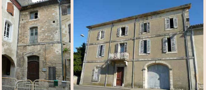
Ici, avec la présence du bandeau et l'alignement des ouvertures, le rythme est vertical et horizontal.
