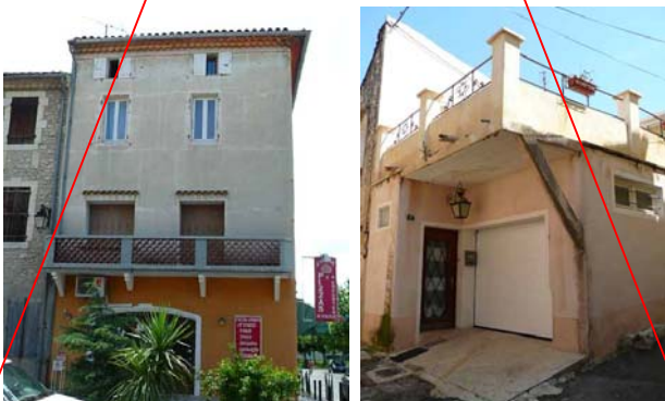
L'adjonction de balcon ne doit pas brouiller la lecture d'une façade. Le recul d'une entrée perturbe l'alignement d'une rue.
