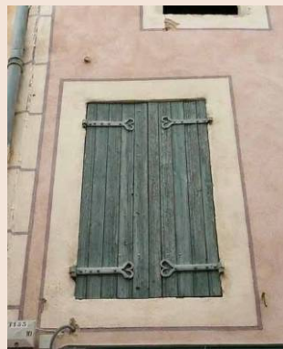
Les encadrements sont badigeonnés d'une teinte plus claire avec un liseré délimitant leur pourtour.
