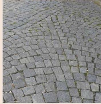
Pavés de granit posés sur lit de sable et jointoyés au sable (Turin, Italie)
