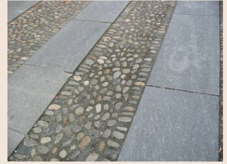
Calade pour l'ensemble de la rue et dalles de granit pour les bandes de roulement (Suse, Italie)
