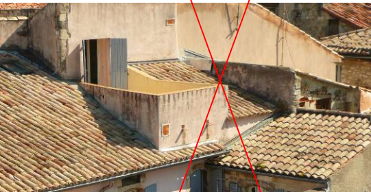
Les terrasses de toit en excroissance.
