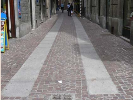
Pavés de Porphyre pour l'ensemble de la rue et dalle de pierre pour les bandes de roulement (Chieri, Italie)
