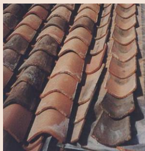
Tuiles canal posées sur chevrons avec étanchéité complémentaire en polyane.
